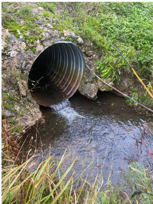
Foto 4 ja 5. Vaade truubi T2 lagunened väljavoolule ja vaade truubi sissevoolu poolt
